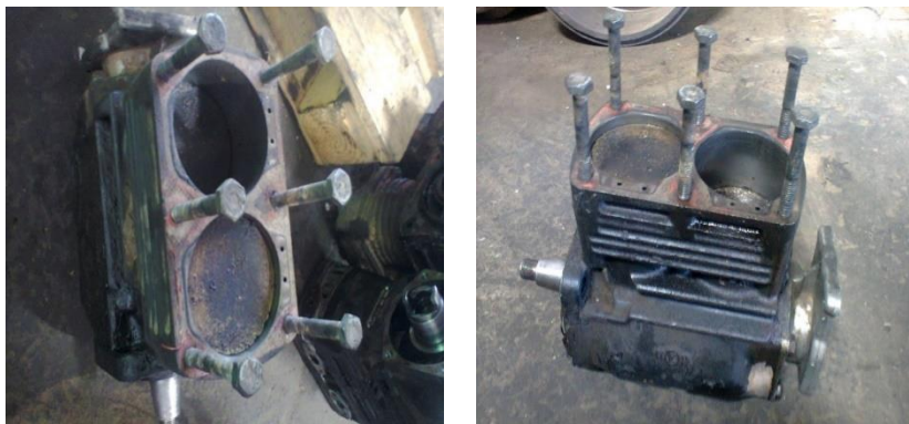
Figure 6 : Le compresseur d'air
