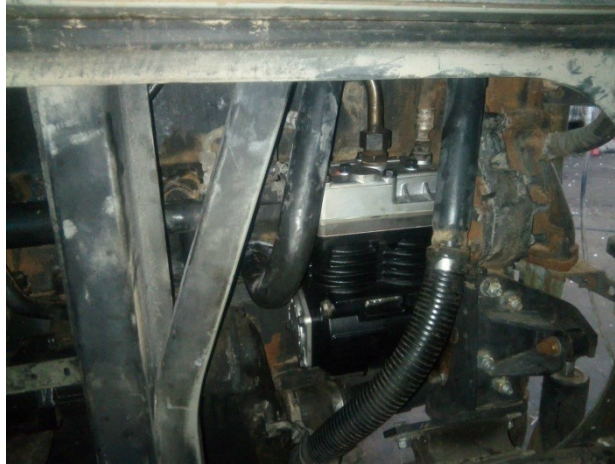
Figure 2. 2: montage d'un compresseur d'air
